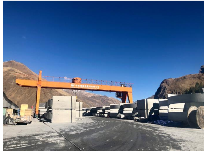
Bau Kobi-Gudauri Tunnel entlang des Nord-Süd-Korridors
